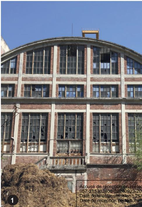
1 bâtiment du carreau Cuvelette en structure béton et remplissage brique
